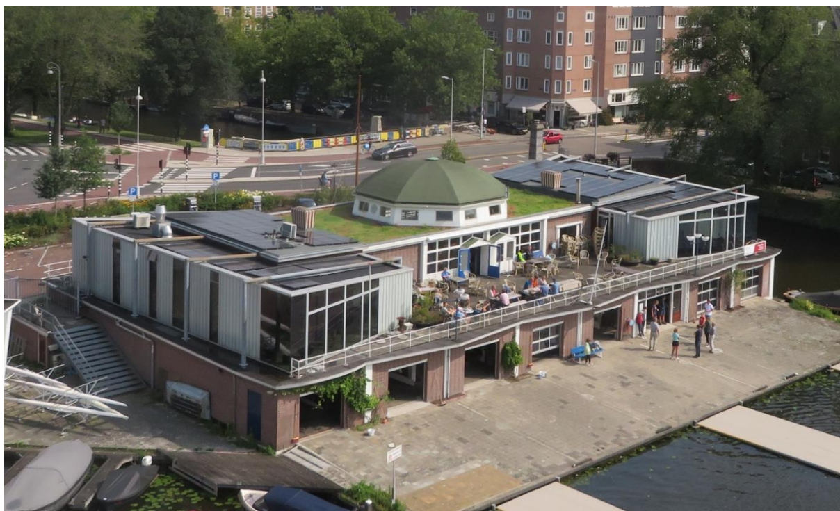
Enkele grote projecten in één plaatje: nieuwe vlotten, nieuwe loodsdeuren, isolatie van dak rondom de koepel (Rc3,5) met mossedum afgedekt, isolatie van de schuine daken daarnaast (Rc2,5), airco's en 94 zonnepanelen.
